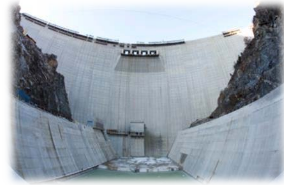
Tsankov Kamak dam, (Bulgaria)
